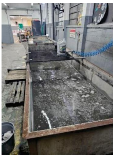
Figura 21: Drenagem dos tanques
