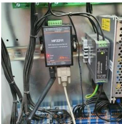
Figura 7 – Detalhe Roteador WiFi/RS-232 - HF2211
